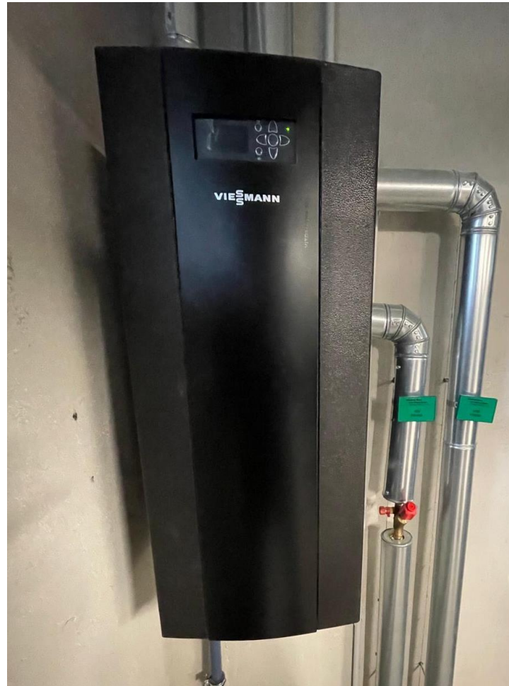
2x Frischwasserstation
