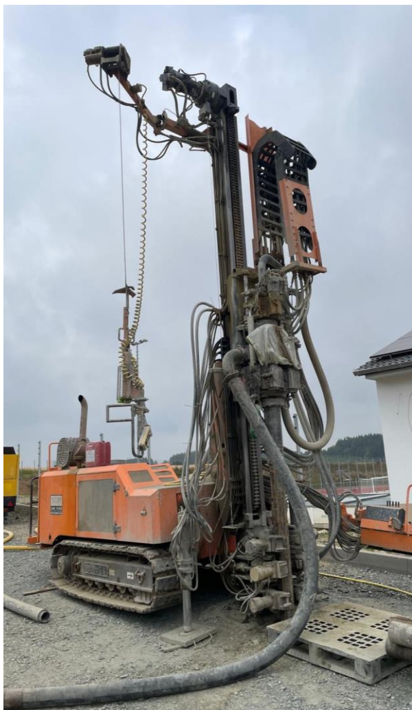
6x 99m Solebohrung
