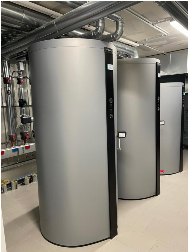
2x 950l Warmwasser 1x 700l Heizungspuffer
